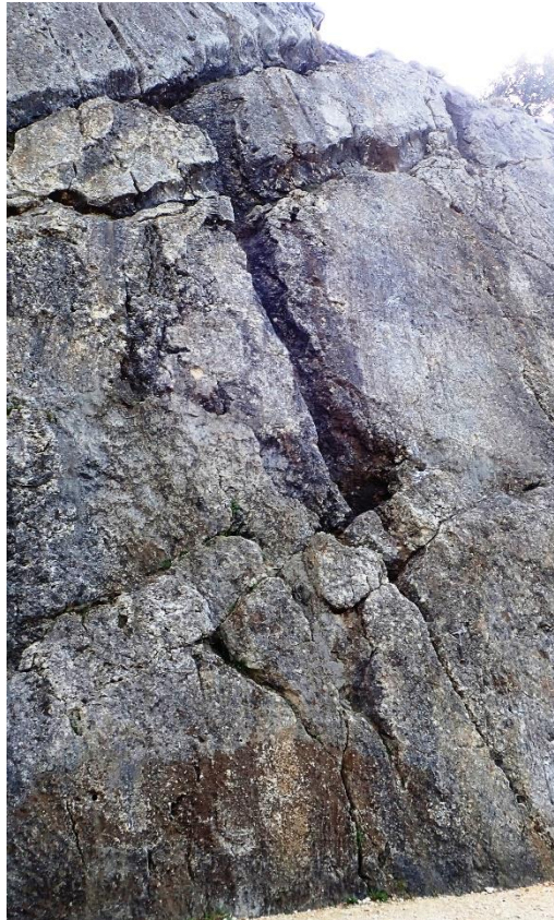
Photo 5: "Pipes" cylindriques visibles sur la paroi calcaire (c4) de la faille de Boisson. (photo: J.Jolivet)
