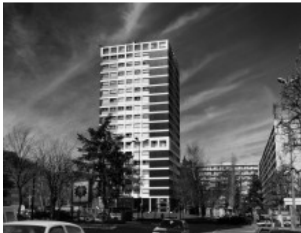
Figure 28. La Tour Borie, à Saint-Etienne, qui a servi de terrain d'expérimentation à la thèse de J. Villot (crédit photo : Cité Nouvelle)
