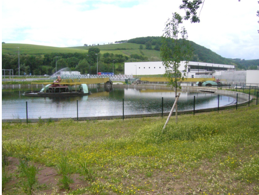
Figure 30. La station d'épuration de Furania, à La Fouillouse
