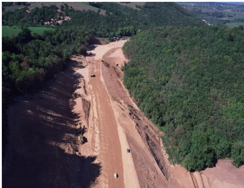
Figure 22. Vue du chantier de déboisement et terrassement pour la mise à 2*2 voies de la RN7 - RN 82 à Vendranges (crédit photo DDE 42)
